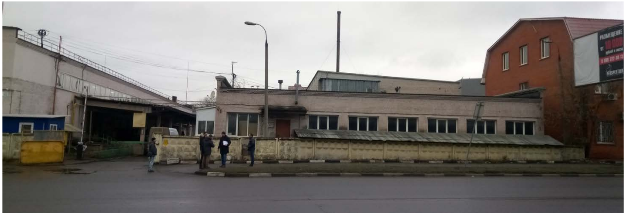
Рисунок 4 – Фотофиксация существующего состояния территории
